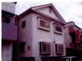
施工後(長崎県住宅)
