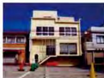
施工後(青森県住宅)
