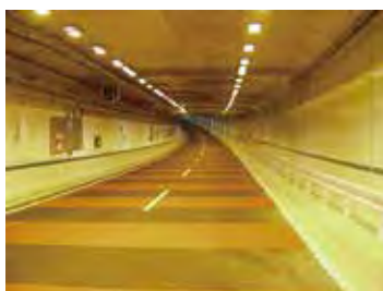
テリオスコート現場施工例 首都高速王子線
