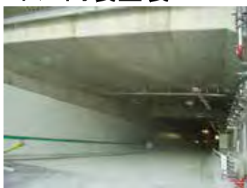
・トンネル内装塗装
