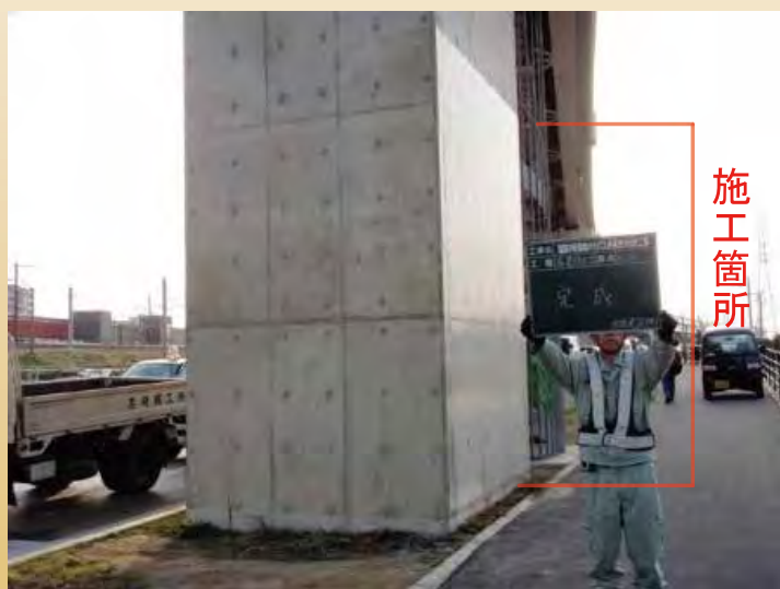
テロスコート美装防汚工法 (テロスコート NP-360QD)
