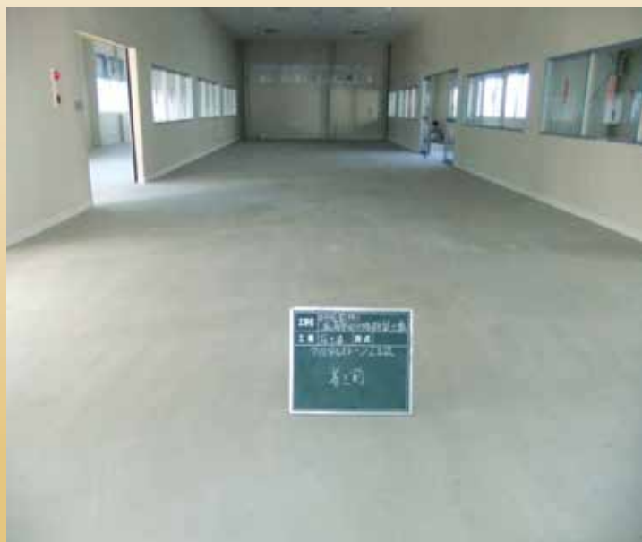
本多産業(株)長崎工場増築工事 着工前
