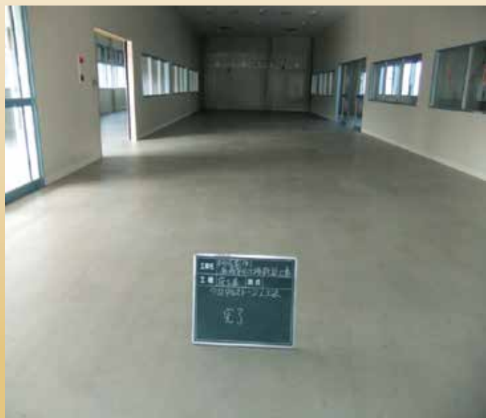
本多産業(株)長崎工場増築工事 完了
